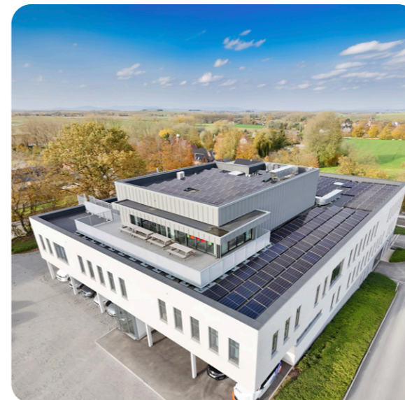
Installation photovoltaïque de la Zone de Police Sille et Dendre
