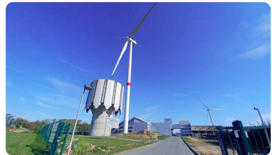
Éolienne sur le site de la SWDE
