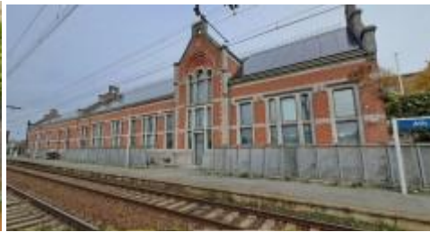
Panneaux photovoltaïques installés sur les bâtiments communaux
