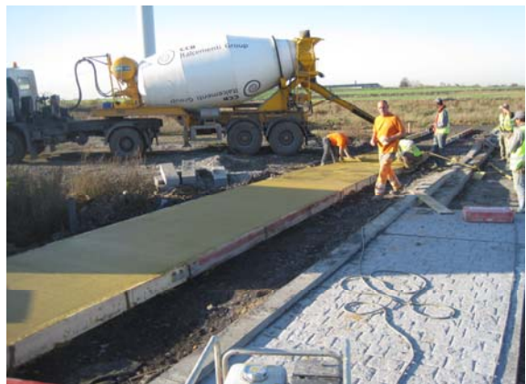
Leuze Europe - construction de trottoirs
