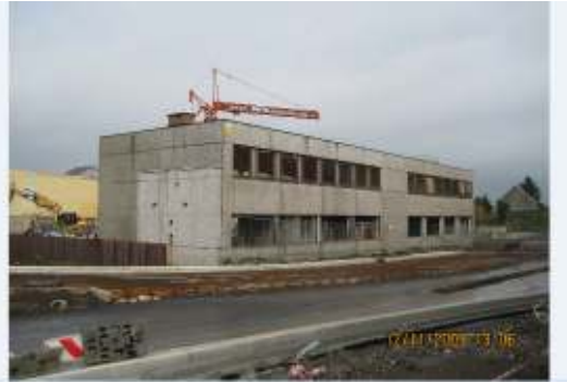
Rénovation de l'immeuble de bureaux
