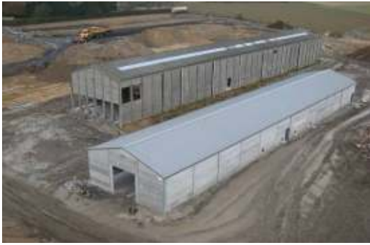
Rénovation des bâtiments-relais
