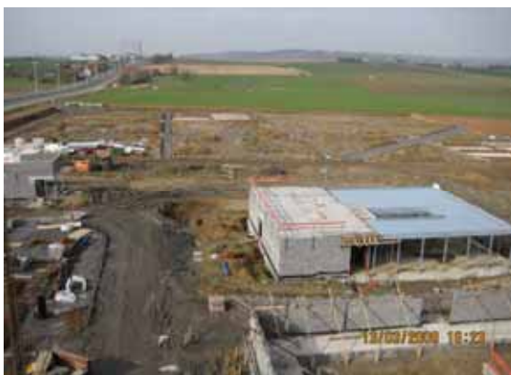
Frasnes-lez-Anvaing - Chantier du Centre funéraire
