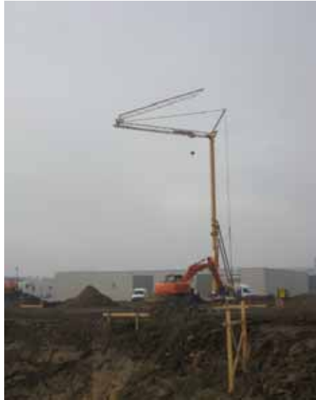
Tournai Ouest - Démarrage du chantier du centre d'entreprises
