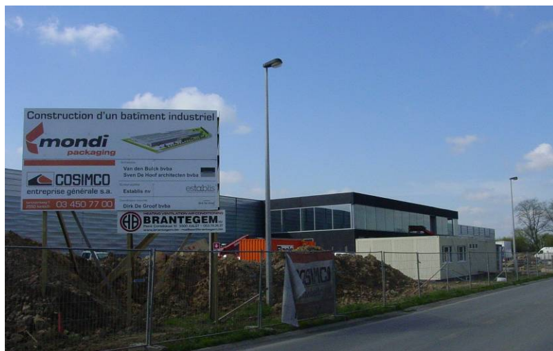
Construction de la nouvelle unité de production de Mondi Packaging à Ghislenghien.
